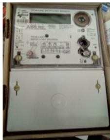
Slika 9: Dvosmerno, trofazno digitalno brojilo
