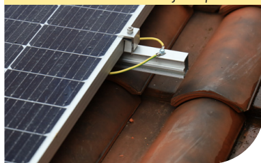
Slika 8: Noseća konstrukcija za panele
